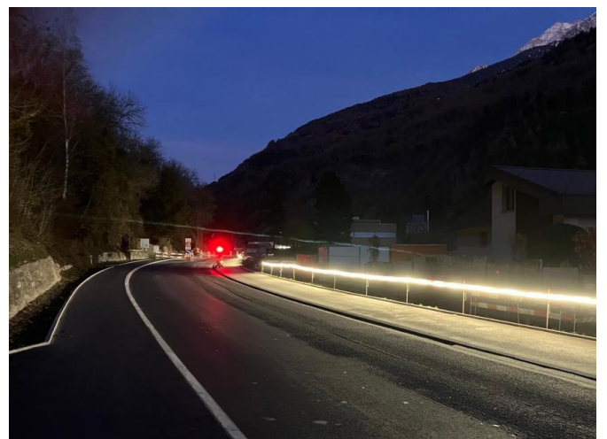
Baustelle Bitsch VS
